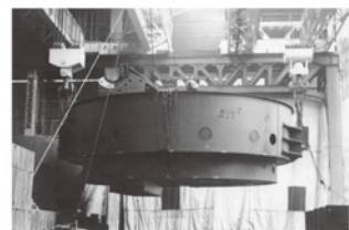
戦艦「大和」主砲塔旋回装置の解体作業終了
