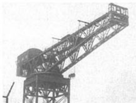
呉海軍工廠に設置された英国製200tクレーン(企画展では、このクレーンの一部分を紹介)
